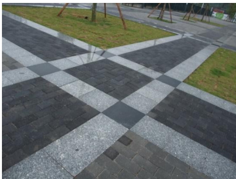
透水铺装地面
