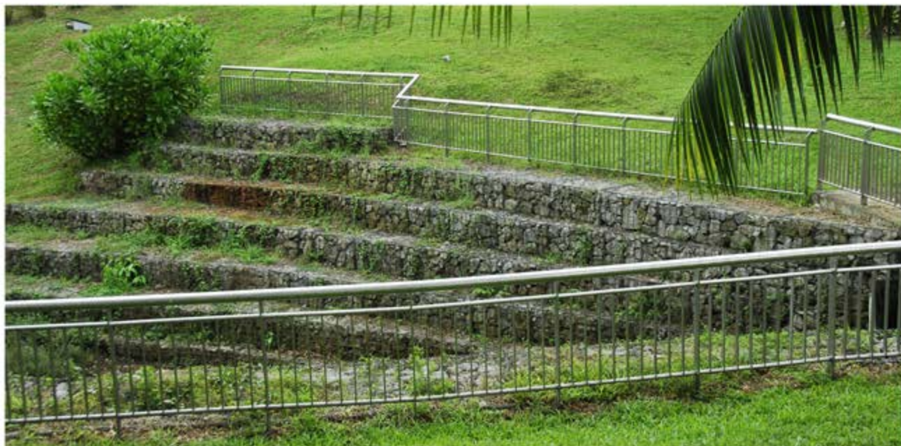
阶梯石笼护坡，对草坡流下的雨水进行过滤，同时具有良好的景观效果
