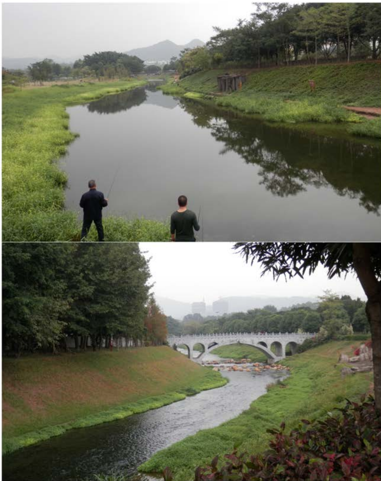
河道两岸植草坡度延长雨水径流时间，促进雨水下渗。
