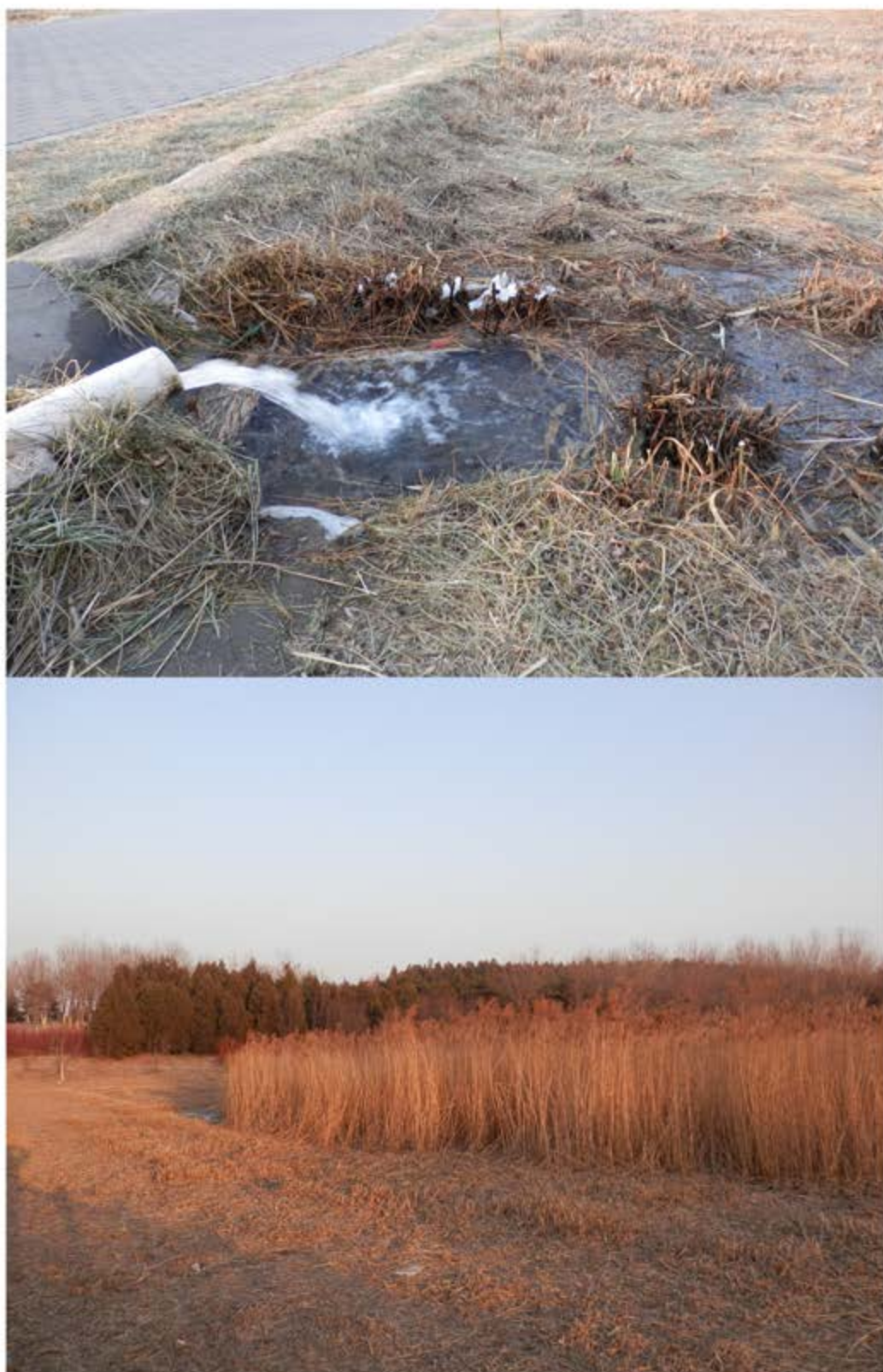
收集的雨水通过 PVC 管道排入人造生态湿地。
