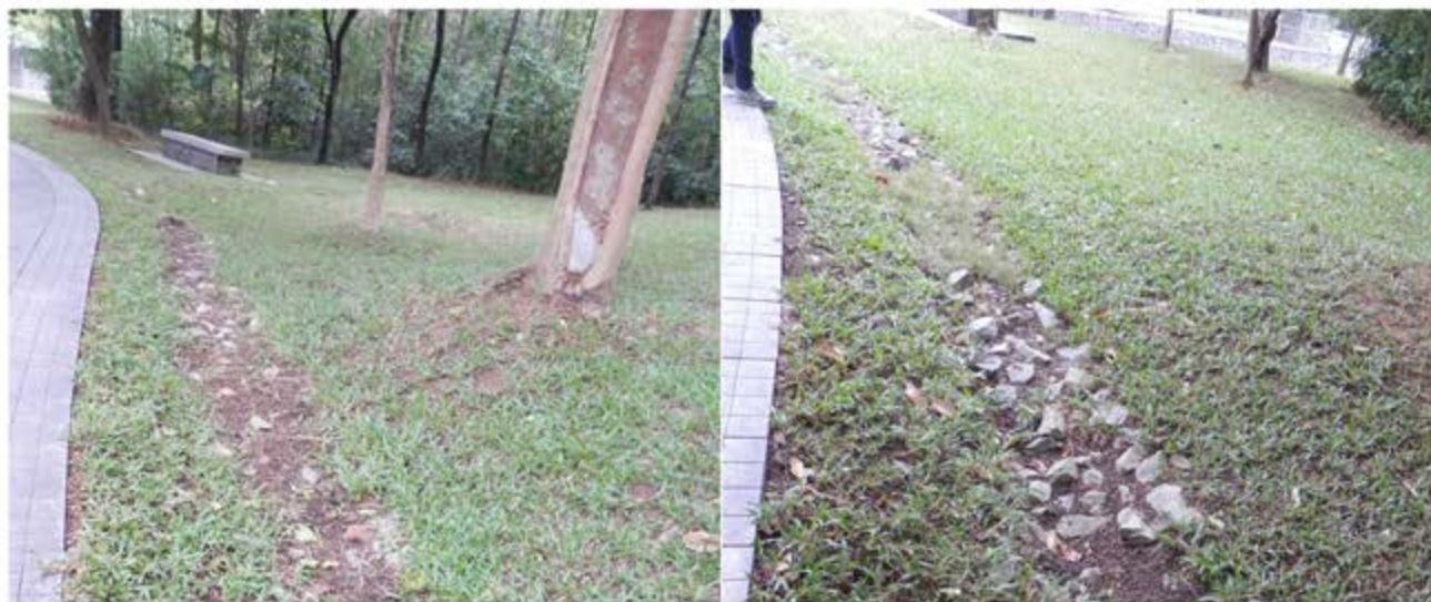
鹅卵石和石块滞留带。对雨水起到过滤、减缓作用。
