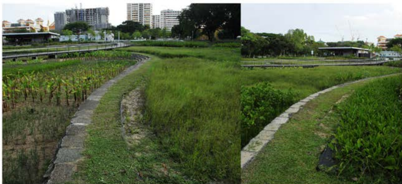
雨水生态净化池，构建多个植物群落层级分布，对雨水进行多层滞留、净化。
