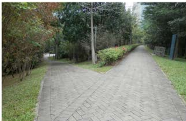
凸型透水路面利于道路雨水进入两侧绿地。
