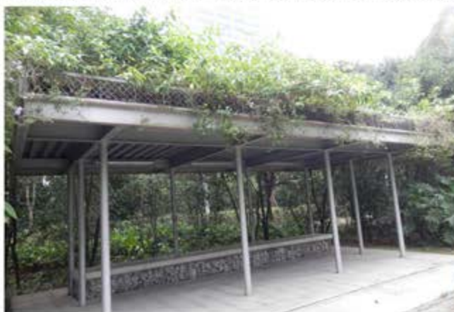
休息棚顶绿化与雨水收集一体化，休息亭顶面略倾斜设置，利于雨水排泄，使雨水能够自然泄落，棚顶采用多种乡土植物，绿化形式植物多样。
