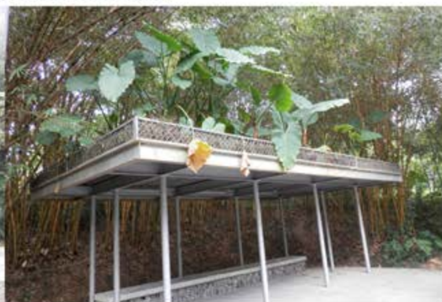
休息棚顶绿化与雨水收集一体化，休息亭顶面略倾斜设置，利于雨水排泄，使雨水能够自然泄落，棚顶采用多种乡土植物，绿化形式植物多样。
