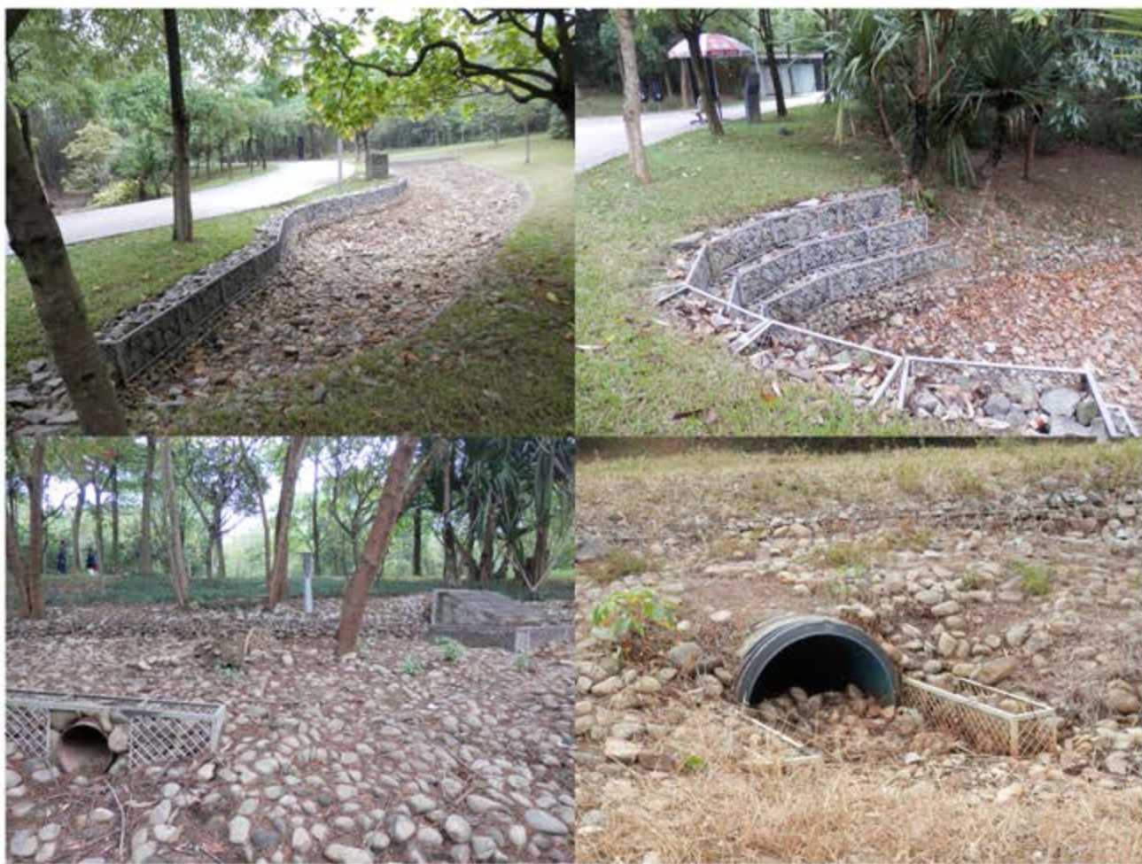
卵石块石滞留池，利用石笼做挡土墙，对进入滞留池的雨水进行过滤，雨水在滞留池中进一步得到过滤后下渗。
